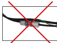
Posición incorrecta del depósito de condensados
