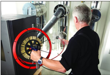
Abb. 5: Reinigung eines Edelstahlschornsteins
