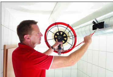
Abb. 6: Reinigung eines Lüftungsrohres
