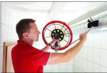
Imm. 36: Nettoyage d'un conduit d'air
